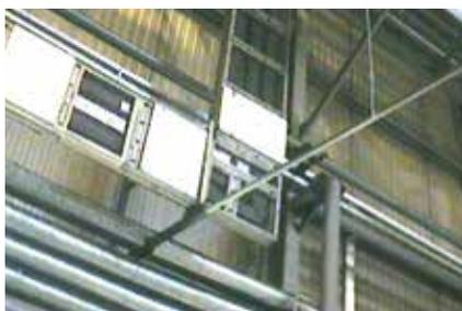
Imagen visual y termografía de un sistema de raíles de barras de una nave de producción.
