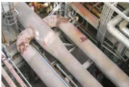
Imagen visual y termografía de una avería en el revestimiento refractario de un conducto de aire.
