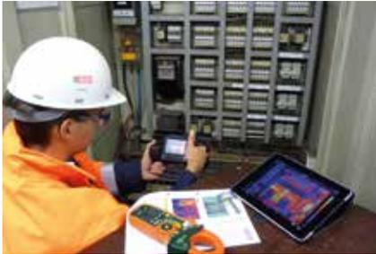
La cámara termográfica de FLIR transfiere las termografías a una tableta PC a través de una red LAN inalámbrica.
