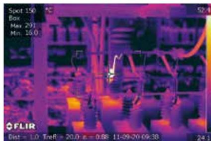
*Esta termografía de un capacitor de alta tensión muestra un punto caliente que indica la existencia una conexión defectuosa.*
