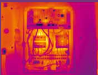
Termografía: 320 x 240 píxeles
