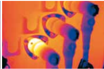
Conexión recalentada
