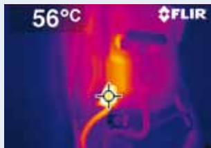
Lo que detecta una cámara termográfica.
