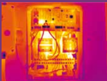
Termografía: 640 x 480 píxeles
