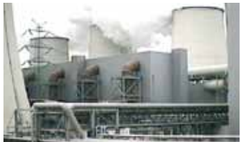
Inspección de aislamiento
